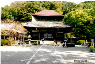
岡山城下の大岡寺本堂
