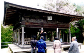
吹き抜けのお堂(半田町捨子)
