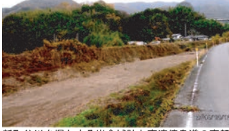
新町谷川を堀とする岩倉城跡と高速徳島道の高架
